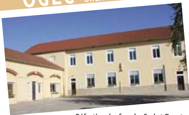
Réfection des façades Sud et Ouest au collège pendant l'été.
